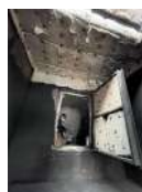
Photo 5 - Isolant dégradé
