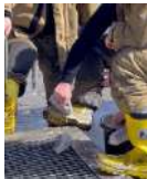
Photo 10 - Nettoyage brossé + eau + savon
