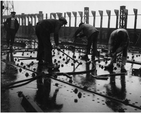
Rivetage des tôles d'un pont de navire. Chantier naval de Penhoët, Saint-Nazaire (Loire-Atlantique), 1931-1932 Donation François Kollar, Médiathèque de l'architecture et du patrimoine
