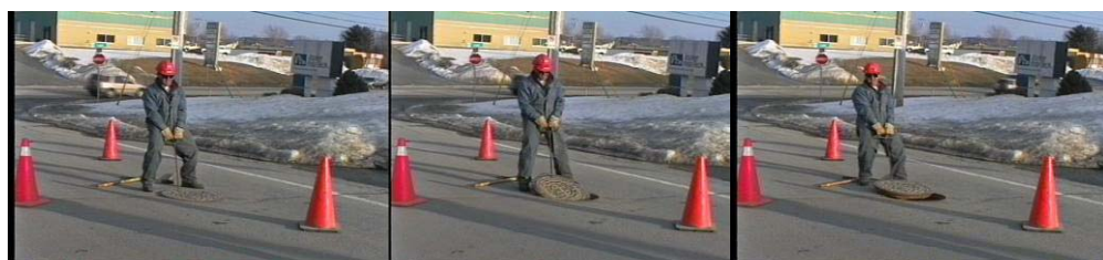
Région sollicitées: épaule (10%); coude (59%) Figure 1: Ouverture d'un tampon à l'aide d'une crochet simple
