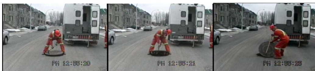
Figure 4: Ouverture d'un tampon à pattes longues à l'aide du pic
