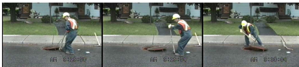
Figure 3: Ouverture d'un tampon à pattes courtes à l'aide du protocole, puis du pic
